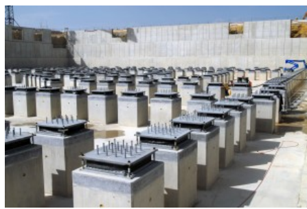
V Cadarache se staví jako o život. Například tyto izolační pilíře proti seismické aktivitě, které budou chránit budovu s tokamakem ITER, byly nedávno vztýčeny v obrovské základové jámě. Zdroj: iter.org
