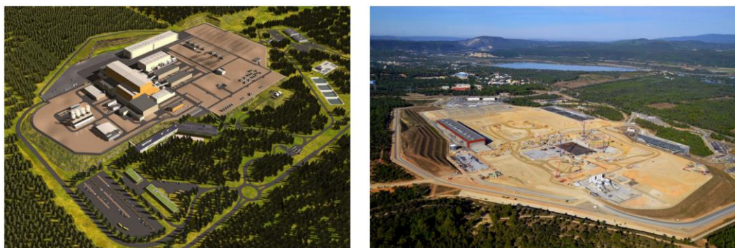
Gambar 2.16 Situs lokasi ITER dibangun (a) bentuk rancangan asitektur dan (b) konstruksi aslinya (Dubus, 2014)
