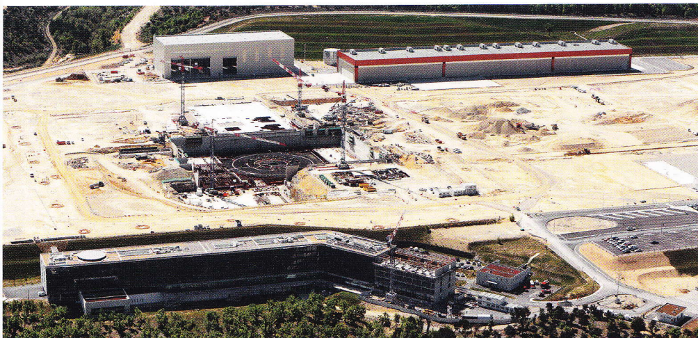
Obrázek č. 5: Staveniště mezinárodního fúzního experimentu ITER. Dobře je vidět základová deska pro tokamak. S laskavým svolením ITER Organization.
