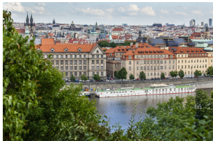
Hlavní budova FJFI v Praze - Břehová
