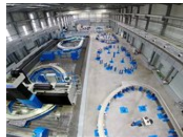
Montážní hala cívek toroidálního magnetického pole ITER - 2014
