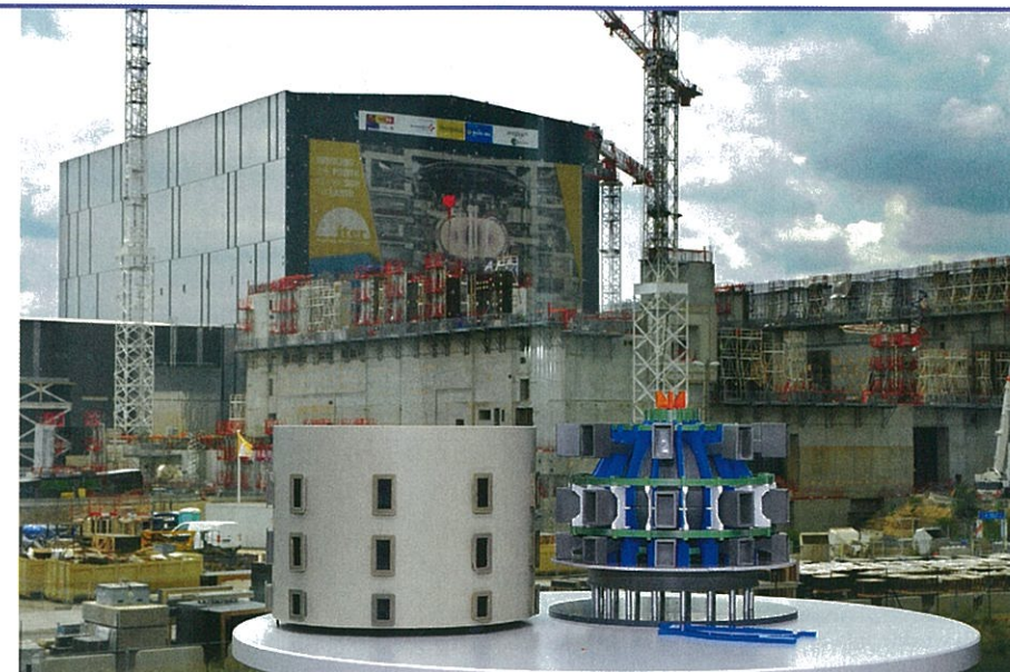
Stavba tokamaku ve Francii vyfotografována přes stavebnici ITERu před montážní halou
