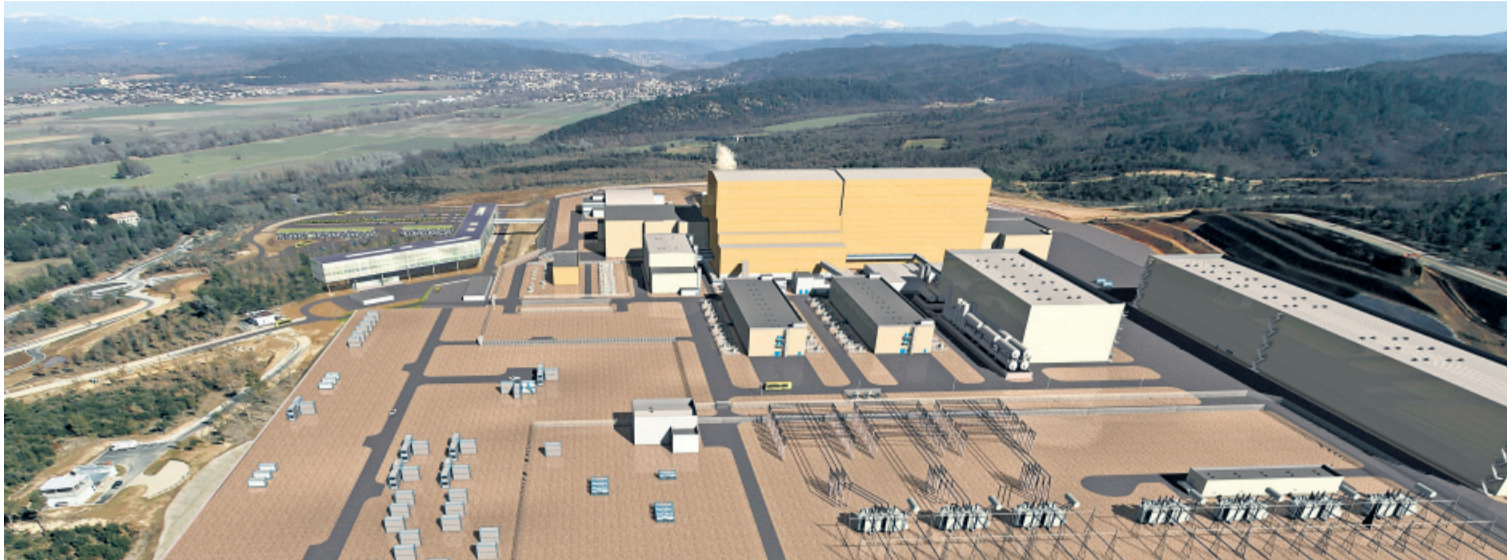
Budoucnost? Takto bude výzkumné středisko Cadarache vypadat, až bude hotové. Reaktor ITER s výškou 29 metrů a průměrem 28 metrů bude umístěn v oranžové budově.
